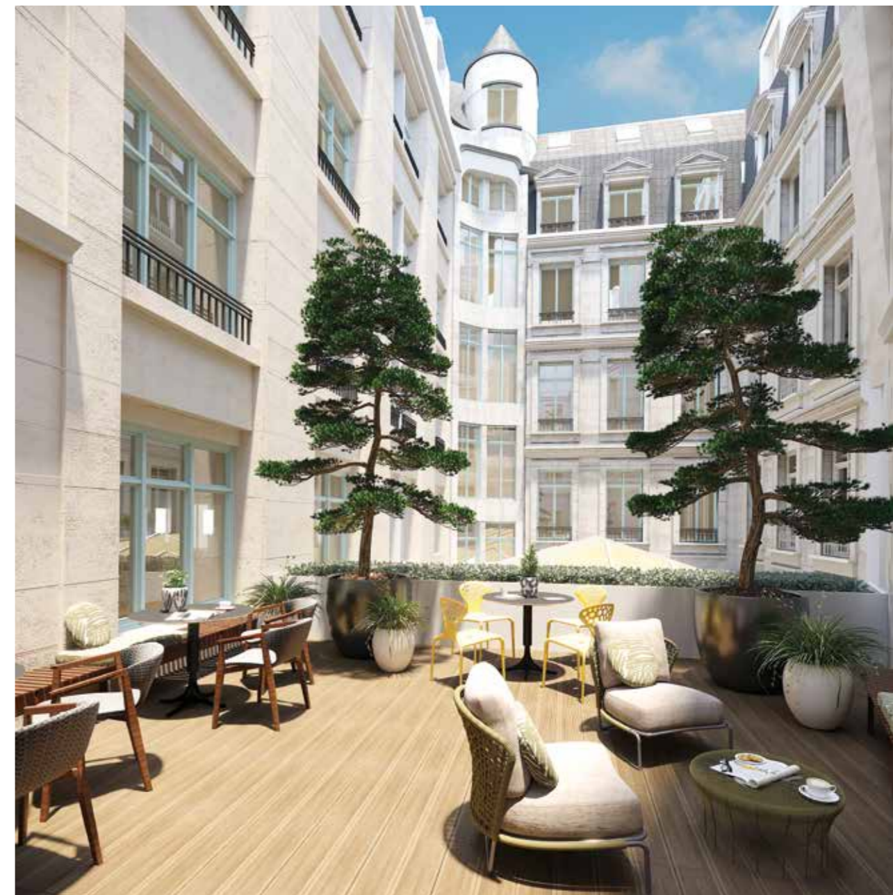
Terrasse accessible au 2 e étage
